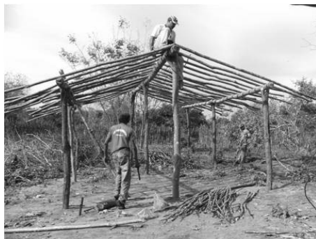
Construção da casa de Renato e Denise na aldeia Mambira
