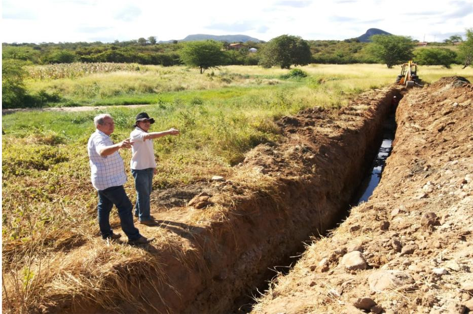
**Figura 03:** Construção de barragem subterrânea em Cachoeira de Araras- BA.
