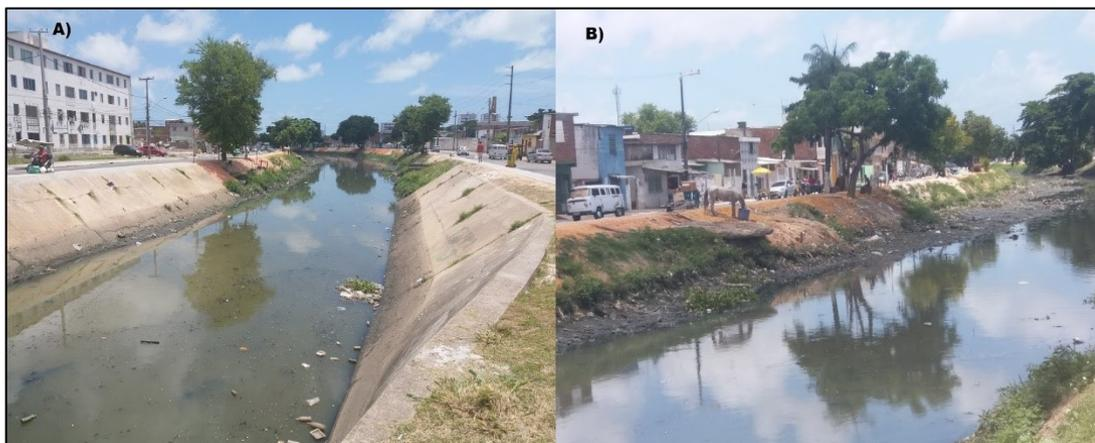
**Figura 04:** A) Trecho 1- canal, em sua parte sinuosa, na transição da área pavimentada e sem pavimentação. B) Trecho 2- parte do canal sem pavimentação, com maior presença de solapamento das margens. **Fonte:** Autor, 2018.
