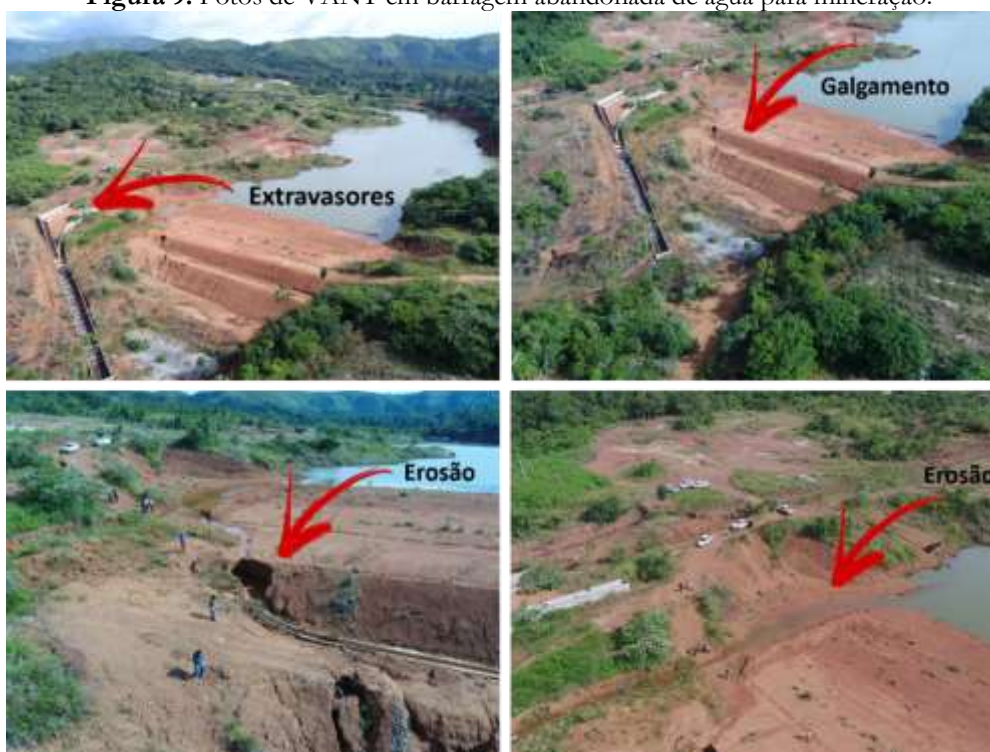
Figura 9. Fotos de VANT em barragem abandonada de água para mineração.
