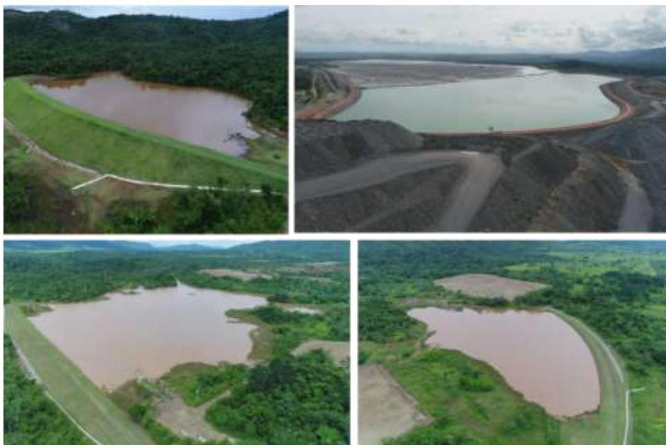
Figura 5. Visão lateral de estruturas de contenção de água e rejeitos de mineração coletadas com VANT.
