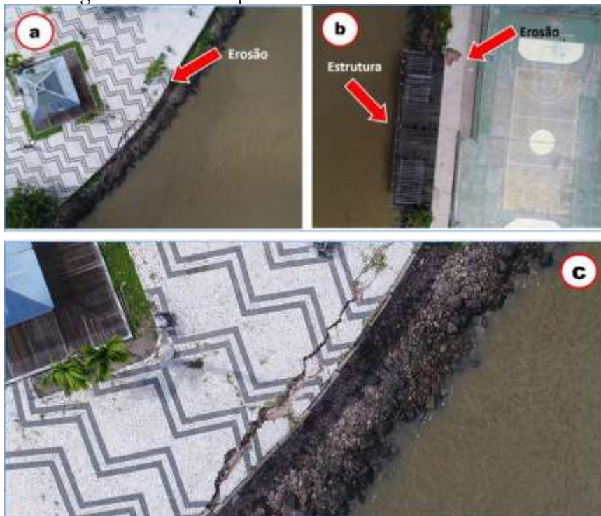
Figura 3. Imagens aéreas com os pontos de erosão e de risco no Portal da Amazônia.
