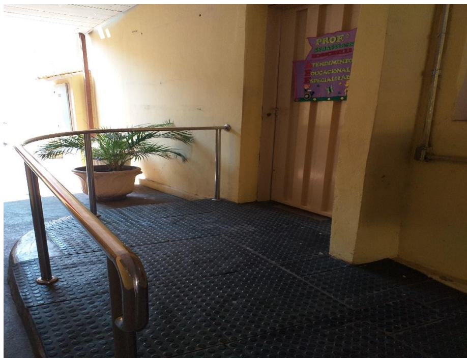
Entrada da Sala Multifuncional/ acessibilidade piso antiderrapante e corrimão.
