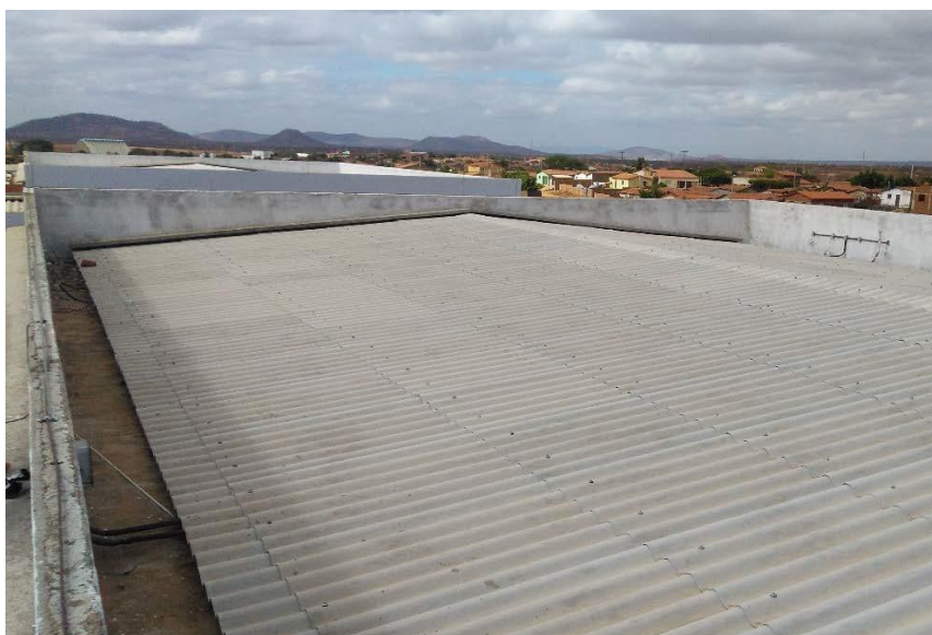
Figura 3. Sistema de calha na cobertura do IFPB-Catolé do Rocha
