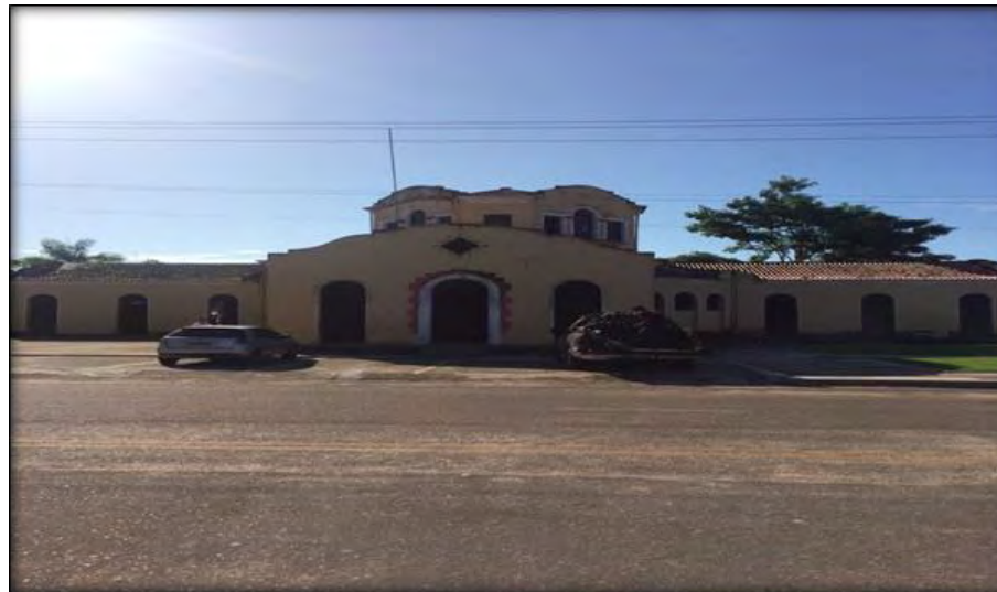
Imagem 07. Antigo mercado municipal de Igarapé Açu
