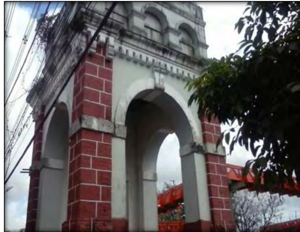
Imagem 02- Caixa d'água, Marituba- Pará
