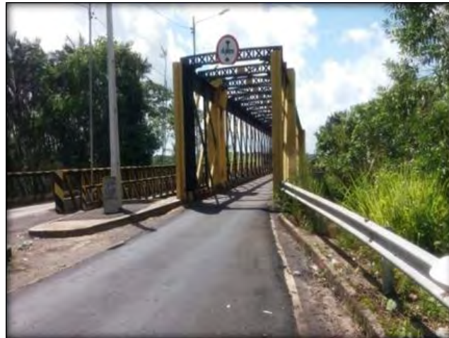
Imagem 09 - Ponte do Livramento.
