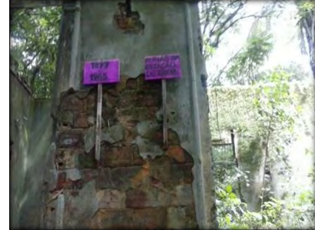
Imagem 10 - Antiga estação da estrada de ferro
