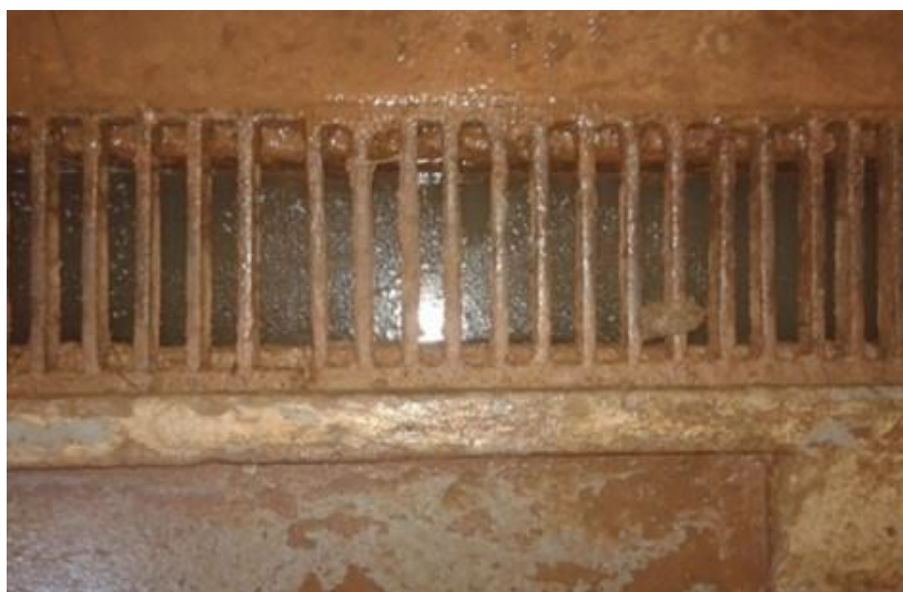
Figura 6. Lançamento de água após lavagem de motocicletas para esgoto público
