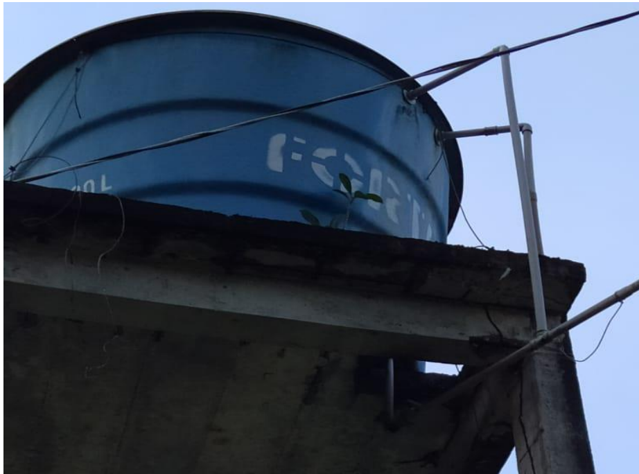
Figura 03: Caixa D'água (reservatório)
