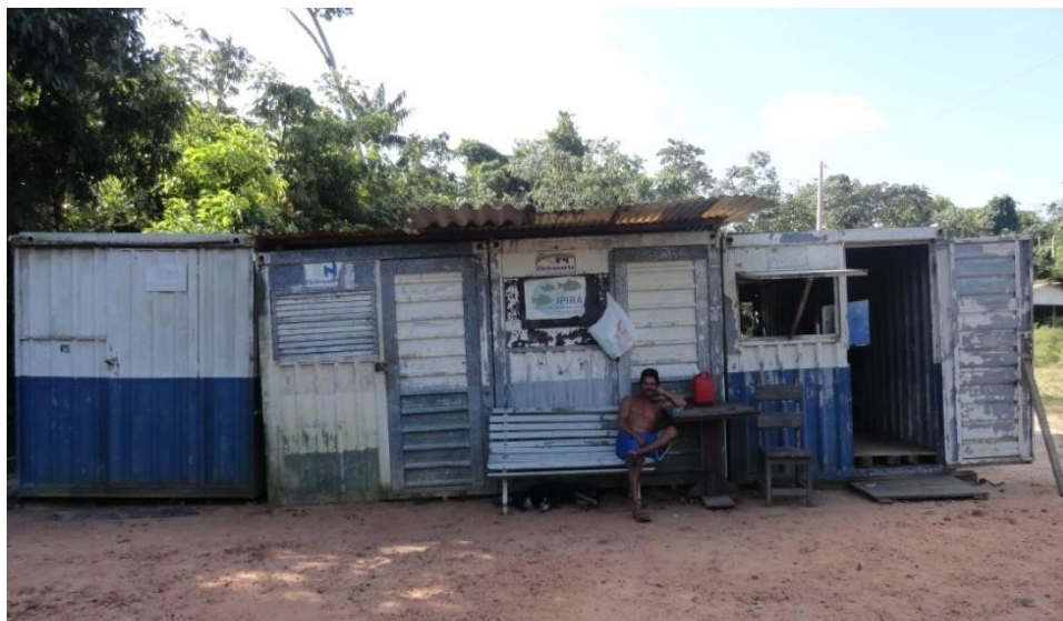
Figura 32: Container anteriormente utilizado para armazenagem de ração.
