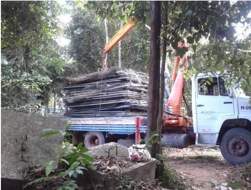
Figura 31: Retirada de tanques redes abandonados.
