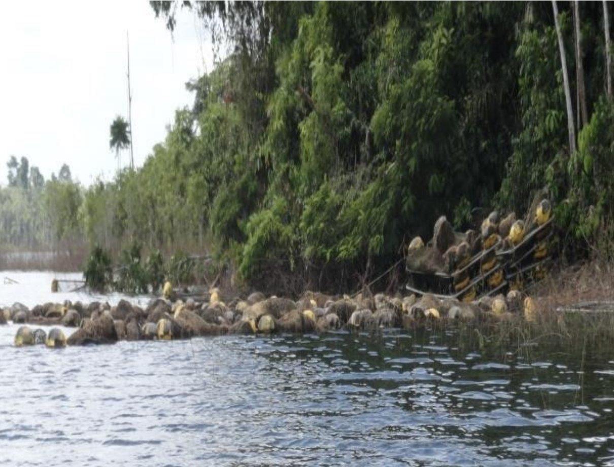
Figura 29: Tanques-redes abandonados pela COOPAT, próximo ao porto do parque aquícola.
