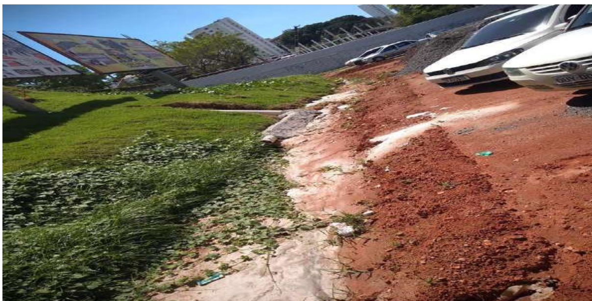
Figura 3 – Terraplanagem para construção de empreendimento às margens do rio.
