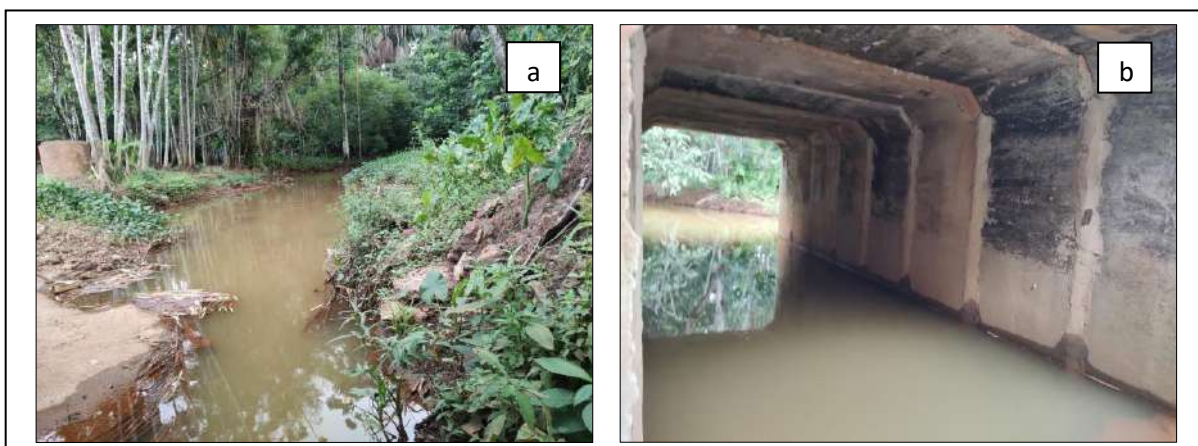
Figura 4 – Registro do Ponto 2: a – vista a montante e b - vista a jusante.
