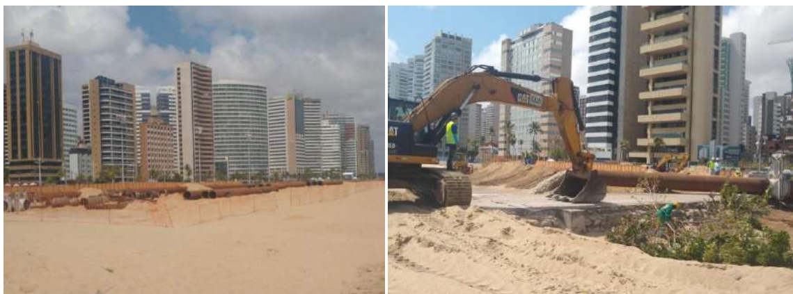
Figura 3 – Obras do aterro hidráulico da Beira Mar em 2019
