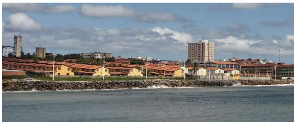
Figura 5 – Muro de contenção protegendo a Av. Litorânea do ataque das ondas, na praia de Icaraí, Caucaia – CE
