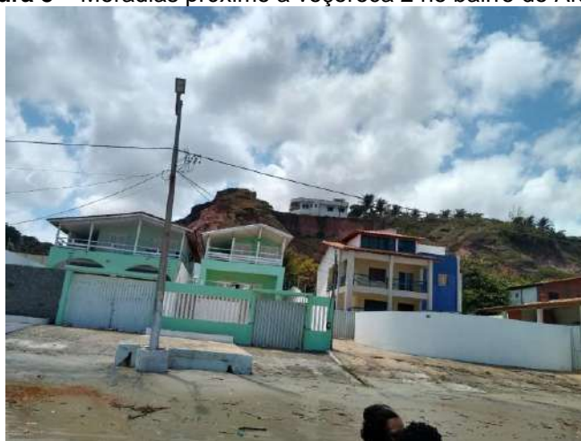
Figura 8 – Moradias próximo a voçoroca 2 no bairro do Araçagi
