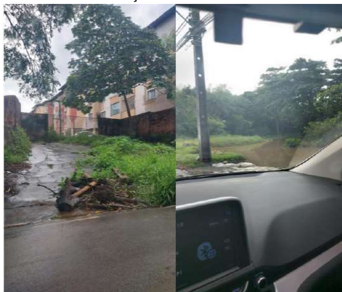
Figura 6: Danos causados a estruturas no bairro do Anil em período de chuvas intensas e inundações no ano de 2023.
