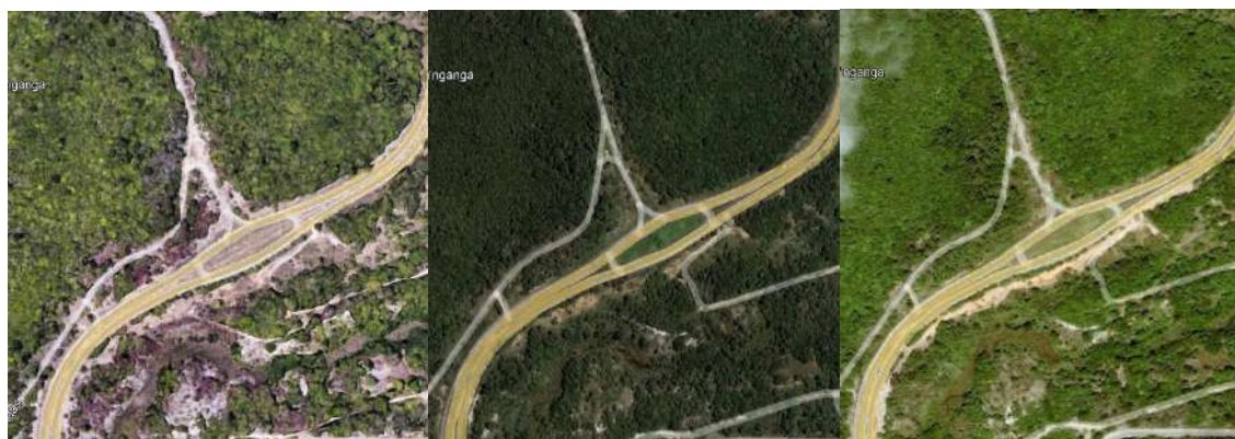
Figura 5 - Trecho da PB 008 em março de 2023, 20/08/2017 e 09/11/2014, respectivamente.
