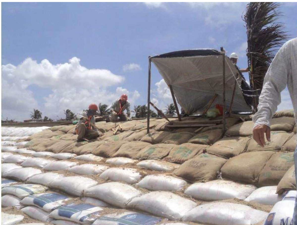
Figura 9 – Utilização da segunda camada (sacos de sisal - estopas) com sementes de vegetação nativas da região – Vila do Mar, Fortaleza - CE.
