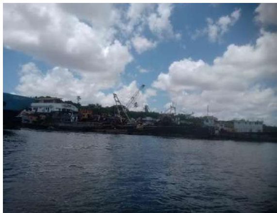
Figura 5 – Estaleiro instalado na planície fluvio-marinha do rio Ceará
