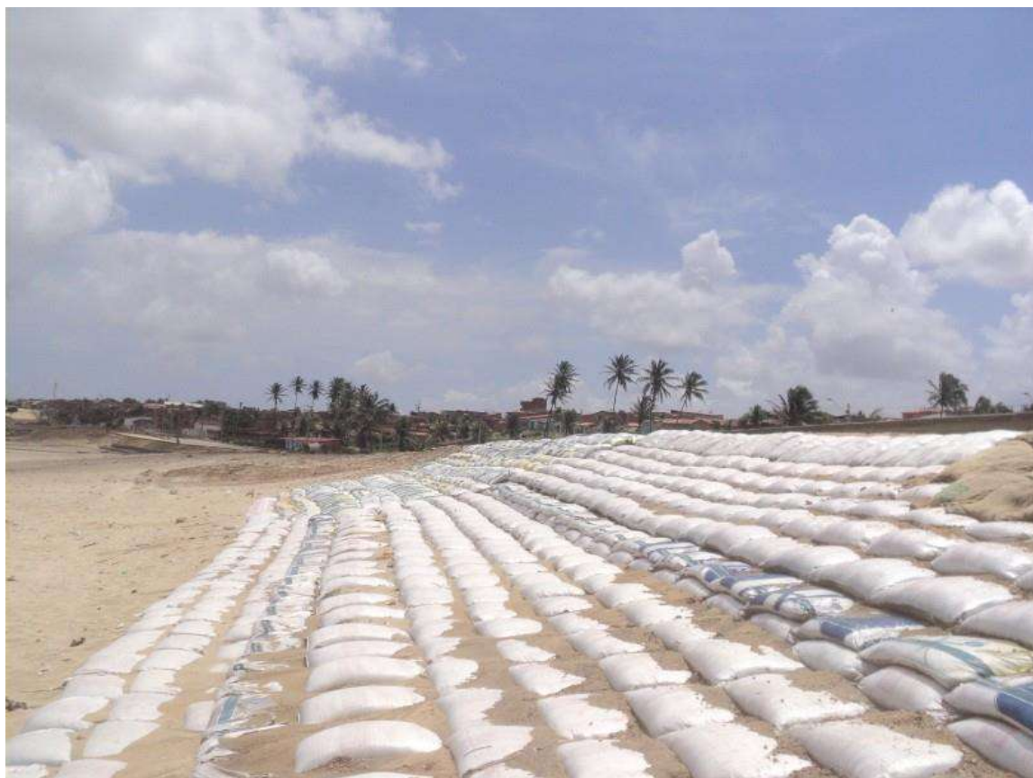
Figura 8 – Utilização da primeira camada (sacos de ráfia) ancorados, empilhados e sobrepostos – Vila do Mar, Fortaleza - CE.
