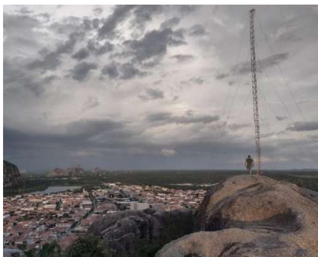
Figura 4 - Antena de telecomunicação instalada sobre a Pedra do Cruzeiro.
