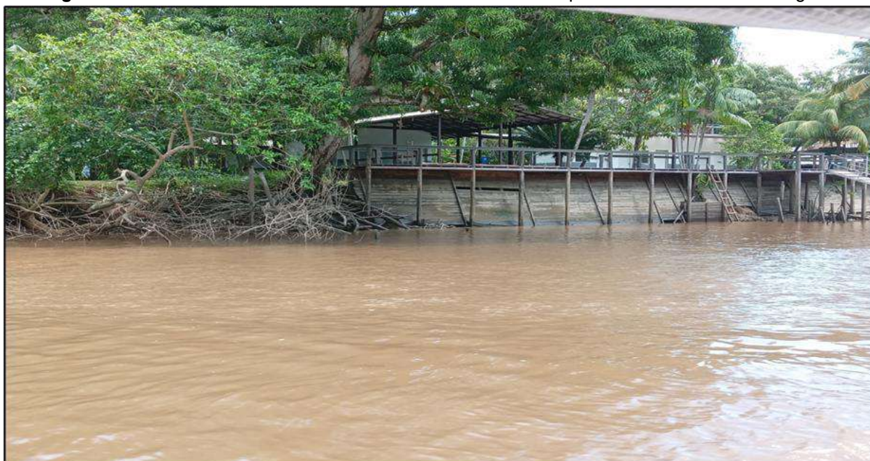
Figura 3 – Estrutura de madeira com a finalidade de retardar o processo de erosão da margem.
