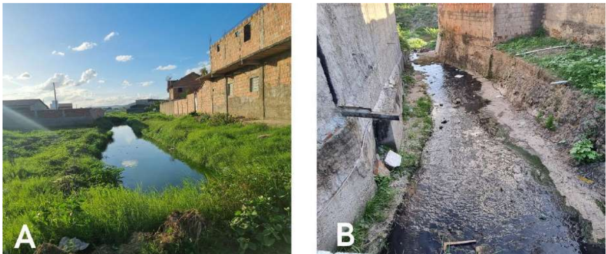
Figura 3 – Canalização do esgoto ao Rio Ingá.
