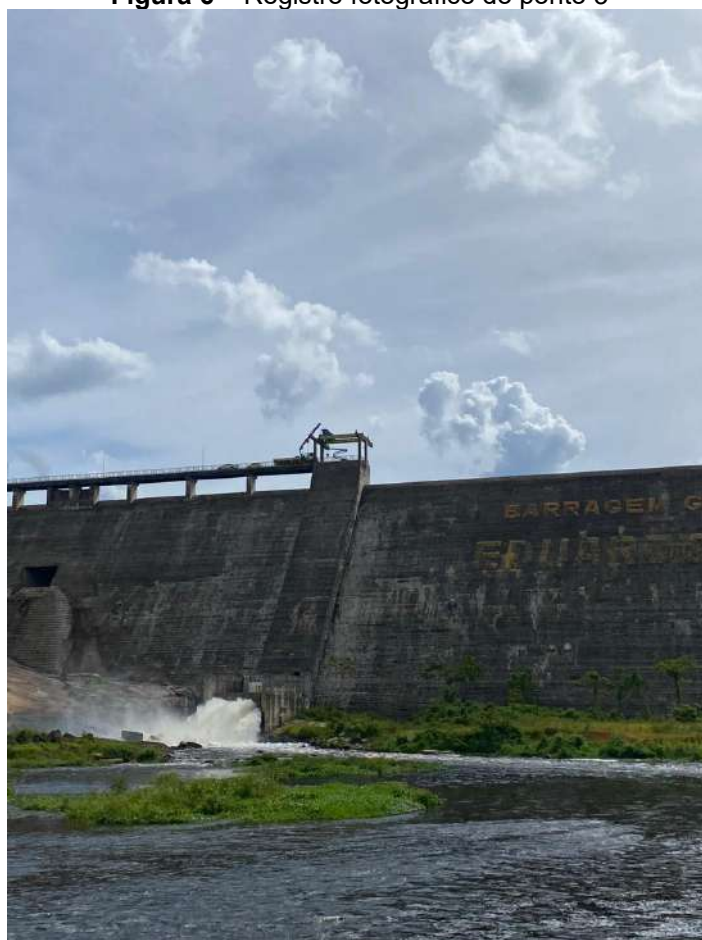
Figura 6 – Registro fotográfico do ponto 3
