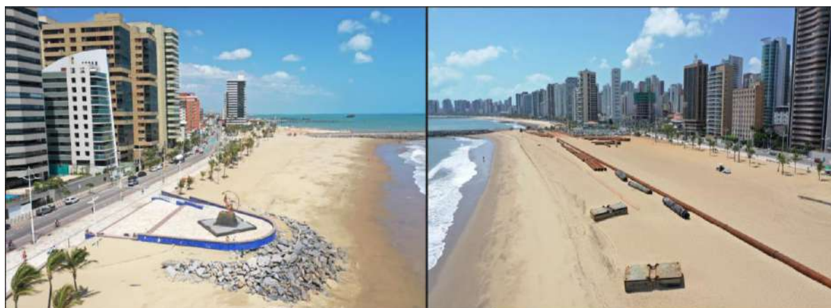
Figura 5 – Obra do aterro da Praia de Iracema.
