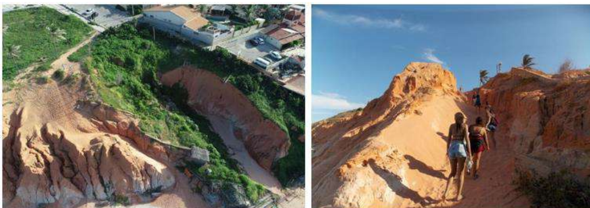
Figura 5 - Deslizamento de terra próximo à Trilha das Jangadas e a trilha homônima.
