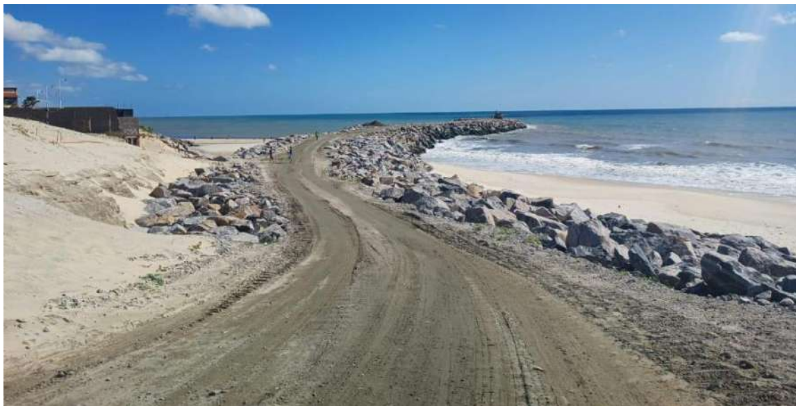
Figura 6 – Molhe senoidal, sendo construído na praia de Icaraí, Caucaia - CE.
