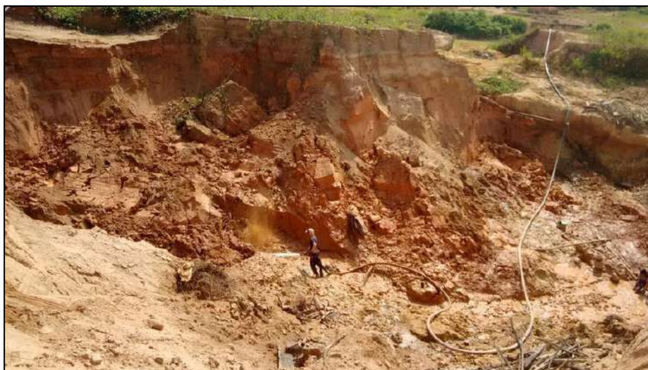
Figura 2: Desmoronamento de barrancos área de mineração do garimpo
