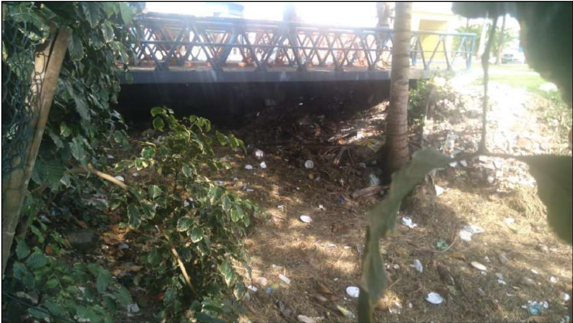
Figura 6 – Tubulação da Ponte.
