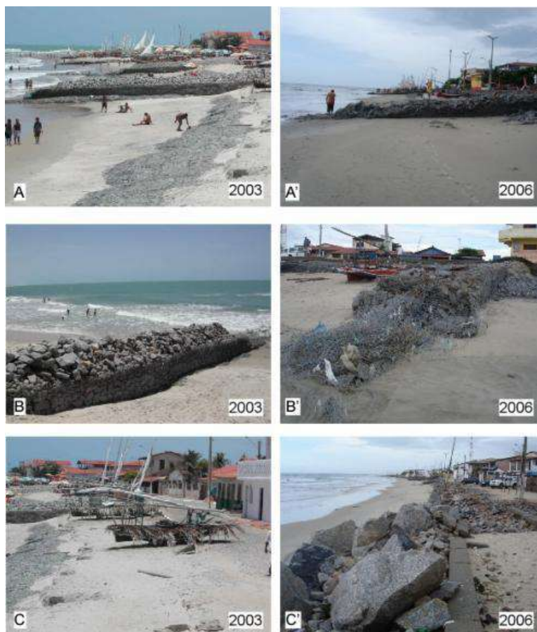
Figura 7 – Evolução da faixa de praia diante da vila da Caponga após a construção dos espigões e muros paralelos à faixa de praia.
