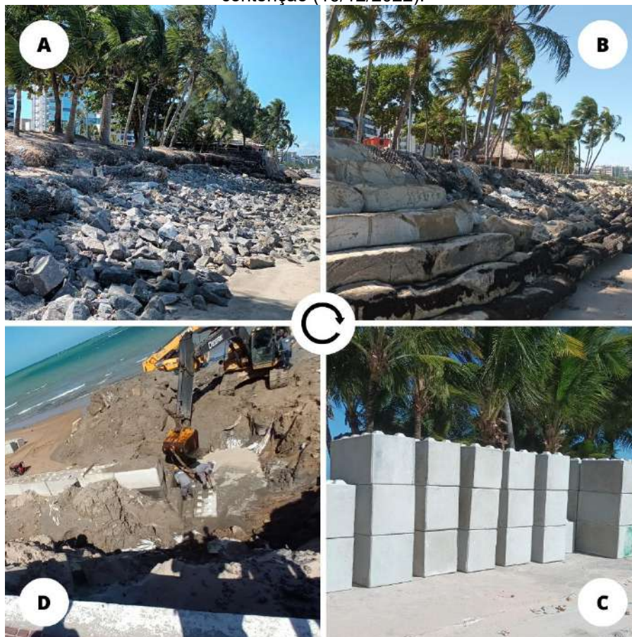
Figura 3 – Intervenções na orla de Maceió – 2022, A: Estrutura de enrocamentos; B: Bagwall colapsado; C: Blocos estruturais empregados na nova estrutura; D: Construção da nova estrutura de contenção (16/12/2022).
