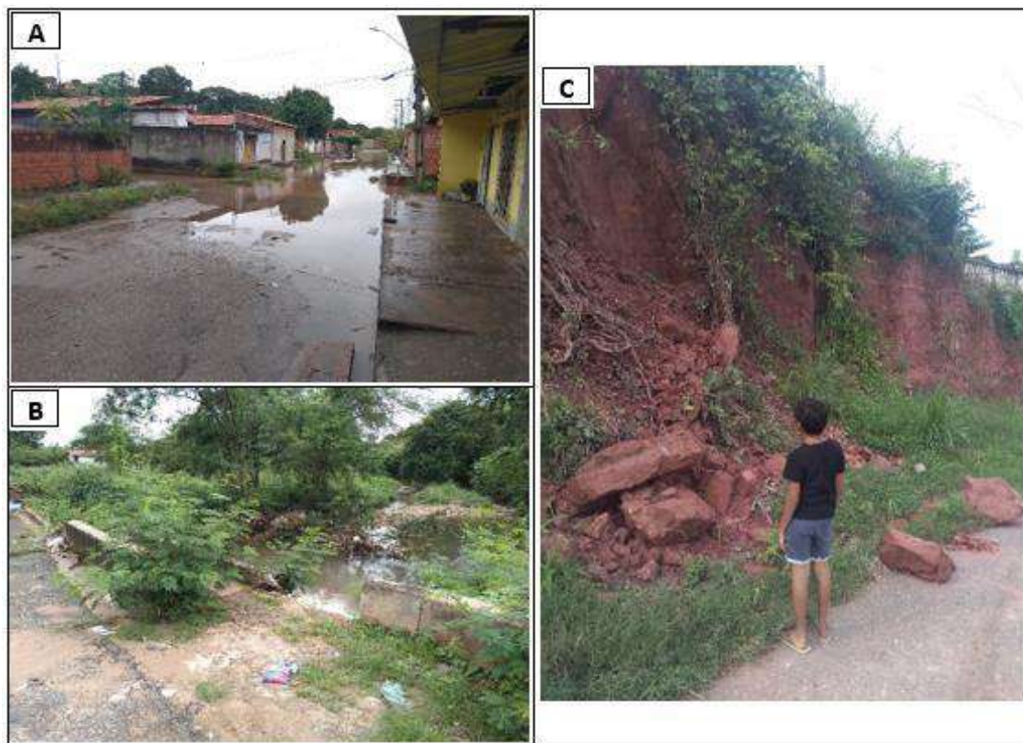
Figura 3 – Locais de alagamentos, inundações e de movimento de massa em Teresina/Pi. Em A, local de alagamento; Em B, local de inundação; Em C, local de movimento de massa (queda).
