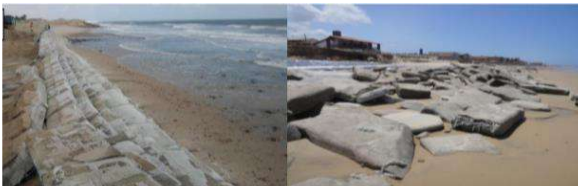
Figura 4 – Estruturas do tipo Bagwall no litoral de Caucaia-CE.
