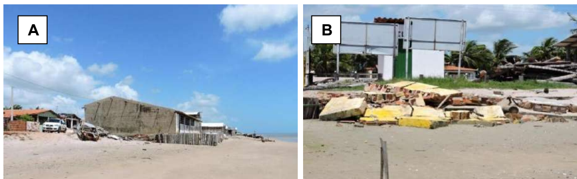
Figura 10 – A: Estrutura de proteção contra o ataque das ondas em Arpoeiras. B: Estruturas urbanas destruídas por processos erosivos na praia de Arpoeiras (2016).
