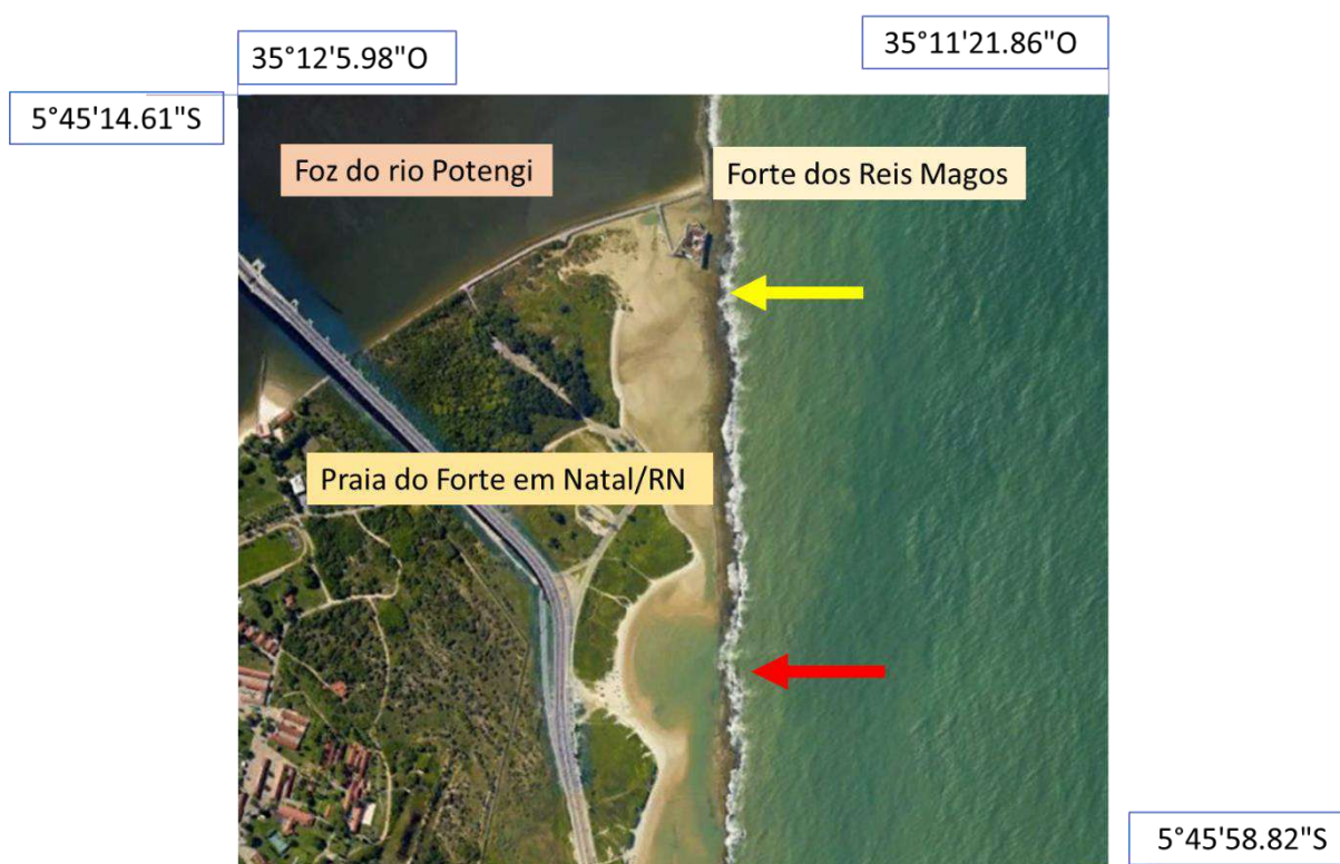
Figura 05- Recuo da linha de costa no setor colapsado dos recifes na praia do Forte em Natal (seta vermelha) e preservação da linha de costa (seta amarela).
