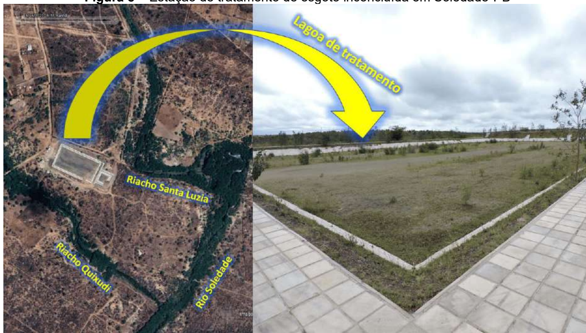
Figura 8 – Estação de tratamento de esgoto inconcluída em Soledade-PB
