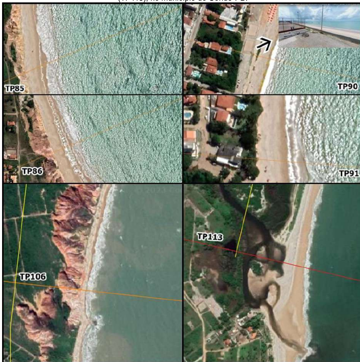
Figura 9 - Transectos referentes à erosão (TP85, TP86, TP90, TP91, TP106) e erosão severa (TP113), no município do Conde-PB.
