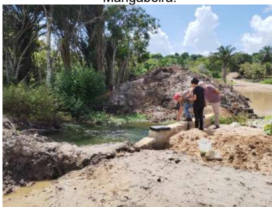
Figura 10 – Obra viária, de iniciativa do governo estadual, ligando a rodovia PB-008 ao bairro de Mangabeira.
