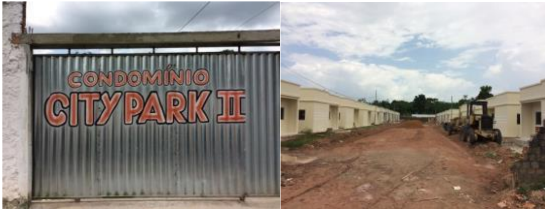
Fotos 14 e 15: Condomínios produzidos na Cidade de Benevides, Distrito de Benfica, mostrando a dinamização do espaço citadino com a inserção do condomínio fechado.
