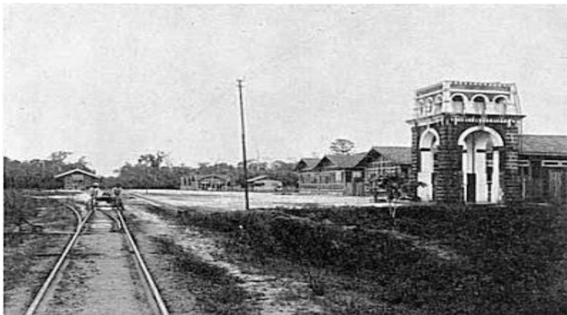
Figura 11: Trecho da estrada de Ferro de Bragança, a caixa d'água, a oficina e algumas habitações situadas no quilômetro dezesseis da ferrovia.
