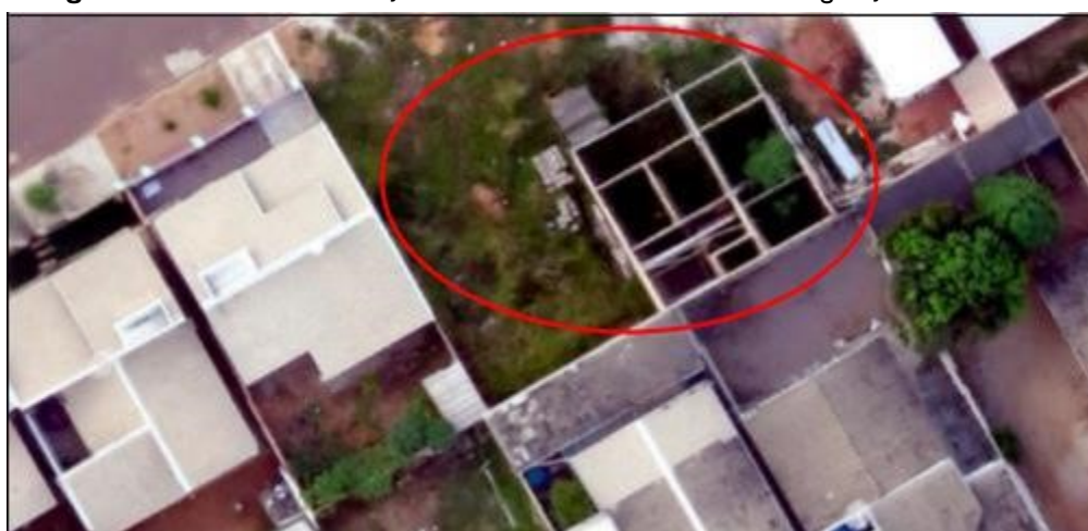
Figura 5: Terreno e construção abandonada e crescimento de vegetação.
