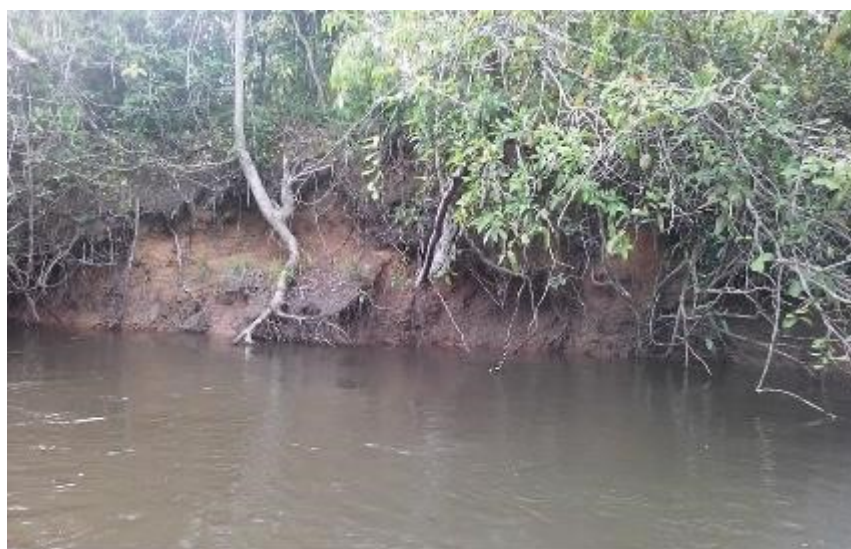
Fig. 3 – Processo erosivo na margem esquerda do rio Cavalão Morto (Próximo à foz).
