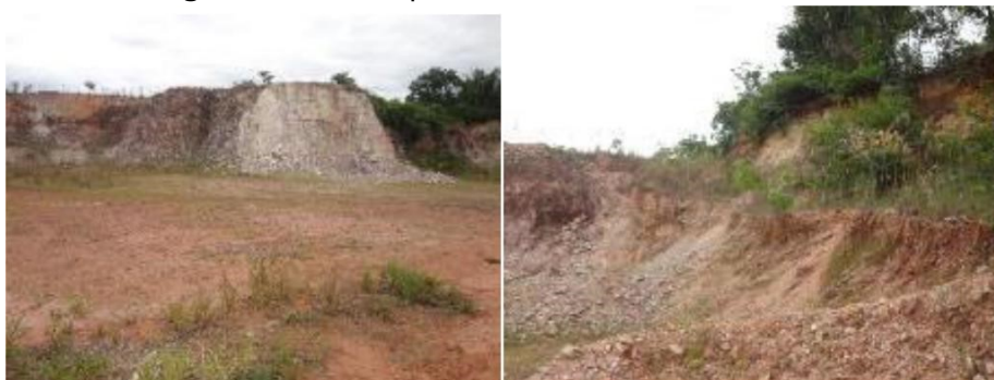
Figura 10. Rocha exposta e locais com erosão em blocos
