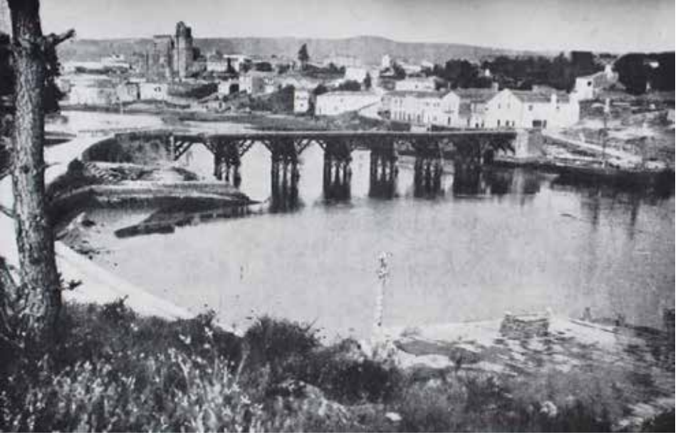
Ponte da Barca/Pontevedra
