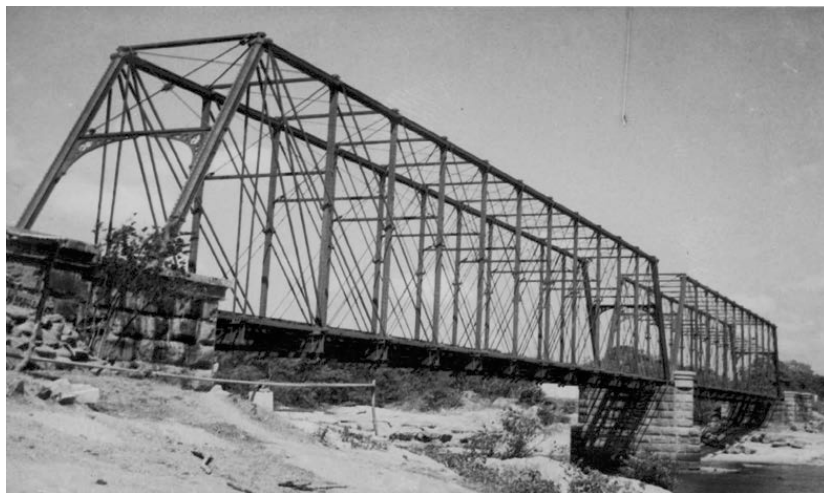
Figura 10. Ponte Metálica sobre o Rio Coreaú. Granja-CE. Fonte: IBGE,
