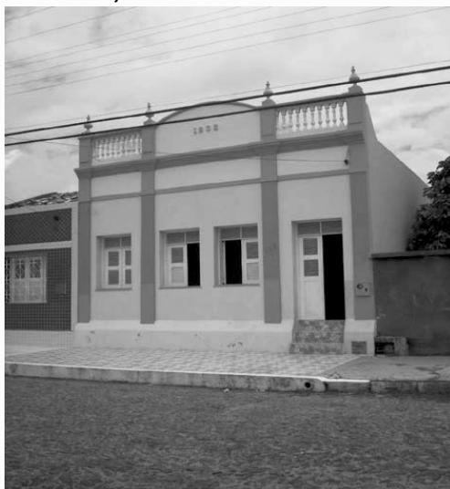
Figura 14. Sede da extinta Associação Beneficente Ferroviária. Camocim-CE. 2007. Foto: Antônio Carlos P. dos Santos – 2007.
