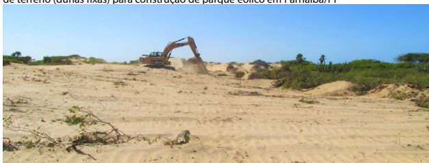
Figura 33: Retroescavadeira em trabalho de supressão de vegetação e nivelamento de terreno (dunas fixas) para construção de parque eólico em Parnaíba/PI
