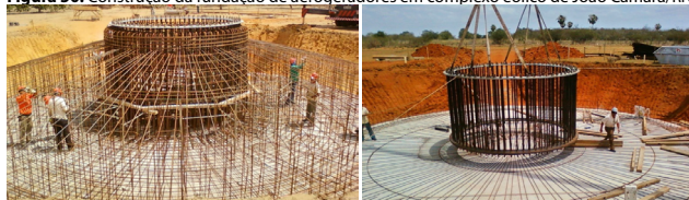
Figura 50: Construção da fundação de aerogeradores em complexo eólico de João Câmara/RN
