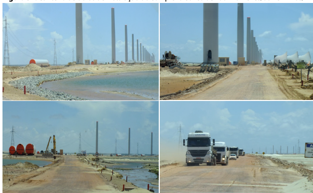
Figura 51: Canteiro de obras de instalação do complexo eólico de Paulino Neves/Barreirinhas/MA
