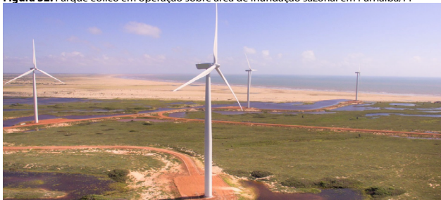
Figura 32: Parque eólico em operação sobre área de inundação sazonal em Parnaíba/PI
