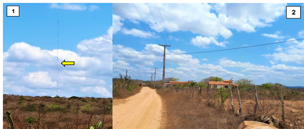
Figura 23: Torre anemométrica (1) e características da paisagem (2) na localidade de Serra da Melosa, Riachuelo/RN
