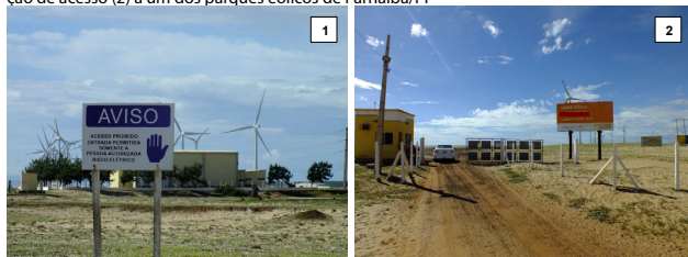
Figura 35: Placa indicativa de acesso proibido (1); segurança, guarita, portão e cerca de restrição de acesso (2) a um dos parques eólicos de Parnaíba/PI
