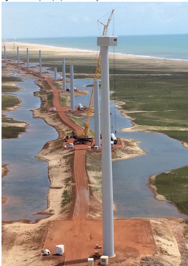
Figura 31: Construção de parque eólico sobre lagoas intermitentes em Parnaíba/PI
