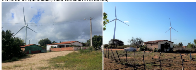
Figura 49: Turbinas eólicas nas proximidades de residências em Patos, Itarema/CE (à esquerda) e Distrito de Queimadas, João Câmara/RN (à direita)
