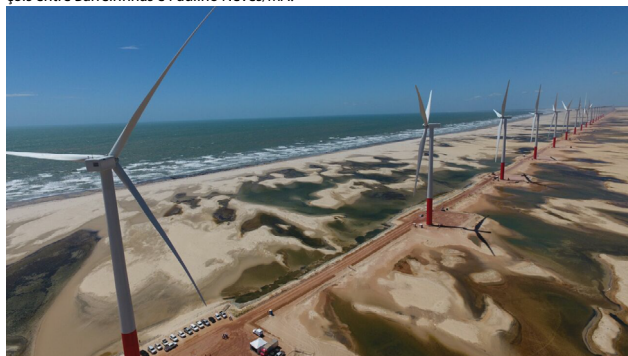
Figura 25: Primeira “bateria” de aerogeradores sobre a planície de deflação dos pequenos lençóis entre Barreirinhas e Paulino Neves/MA.
