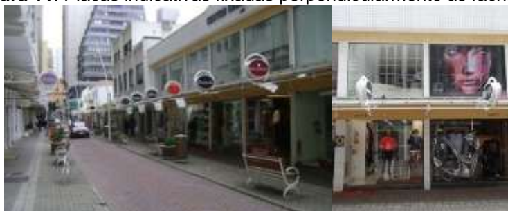
Figura 11: Placas indicativas fixadas perpendicularmente às fachadas
