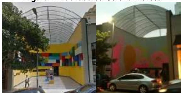
Figura 4: Fachada da Galeria Melissa
