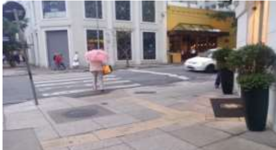
Figura 3: Piso tátil sem continuidade ao longo da calçada.
