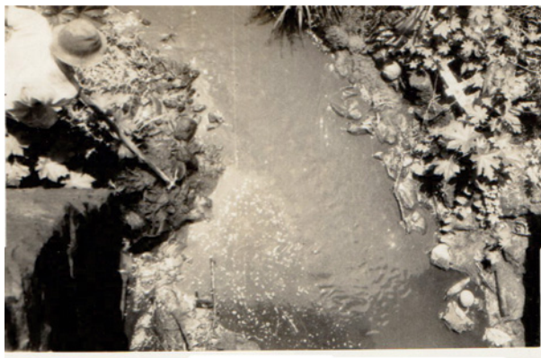
Canal de Jacarecanga que serve de escoamento de águas servidas de três indústrias
