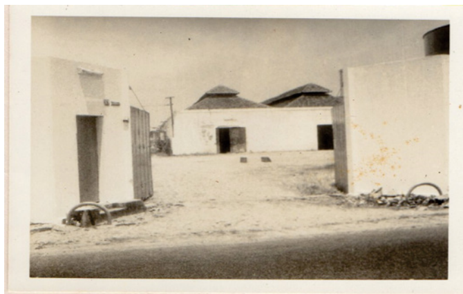
Entrada da Fábrica Indoil - encampada pela Alumínio Ironte, Av. Francisco Sá.
