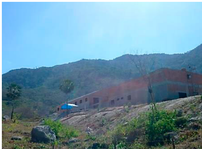
Figura 12 – Construções na sede municipal de Pacatuba. a) construção em área com declividade menor e abaixo da cota de 100 m; b) construção em área com elevação acima da cota de 100 m
