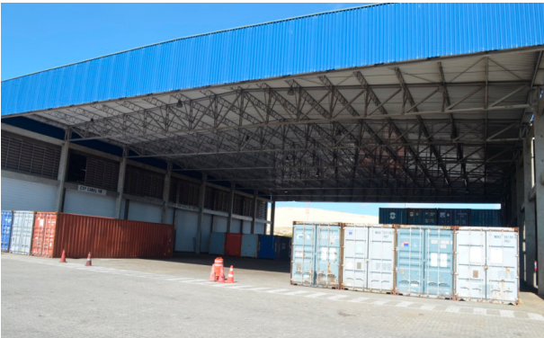
Figura 17 – Pátio de armazenagem coberto do porto do Pecém
