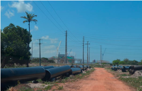
Figura 31 – Infraestrutura, em construção, para transportar água do reservatório da COGERH à CSP.
