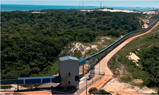
Figura 14 – Trecho da correia transportadora sobre o campo de dunas
