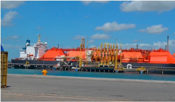
Figura 09 – Terminal 2 do porto do Pecém com navio petroleiro permanente da PETROBRÁS
