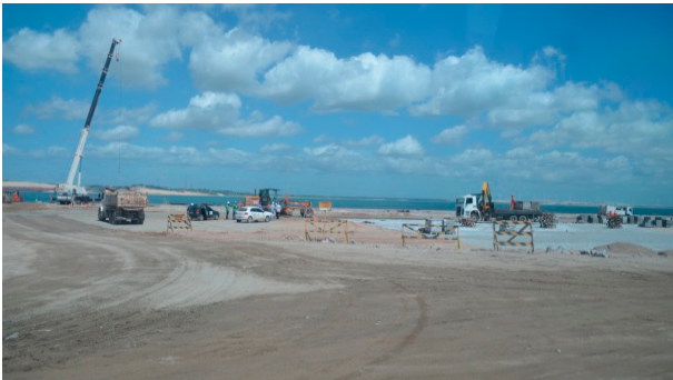
Figura 11 – Obras de ampliação do terminal 3 do porto do Pecém
