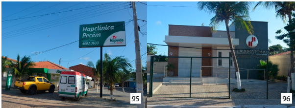
Figuras 99 e 100 – Estabelecimentos de saúde implantados recentemente no distrito de Pecém
