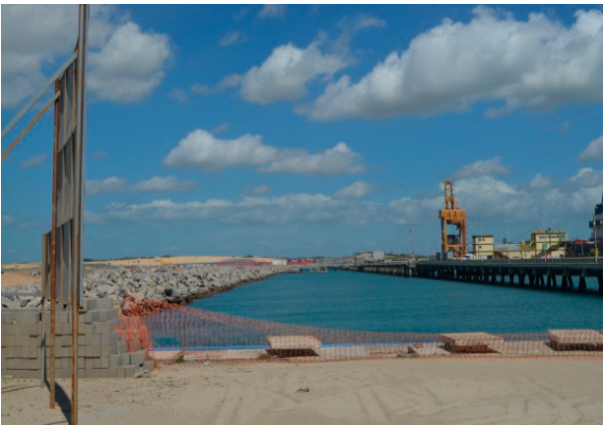
Figura 06 – Ponte paralela à ponte de acesso principal em construção no porto do Pecém.
