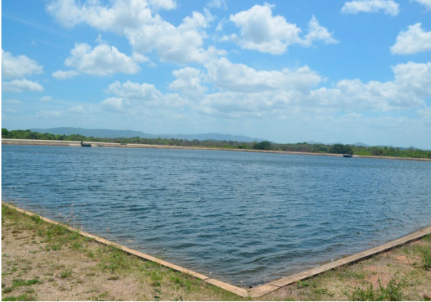
Figura 30 – Reservatório da COGERH, localizado no CIPP e ligado ao trecho 5 do Eixão das Águas.
