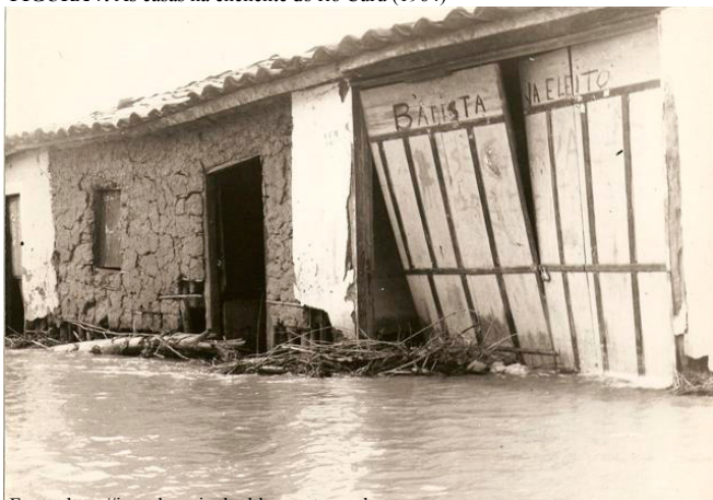
FIGURA 7. As casas na enchente do rio Curu (1964)
