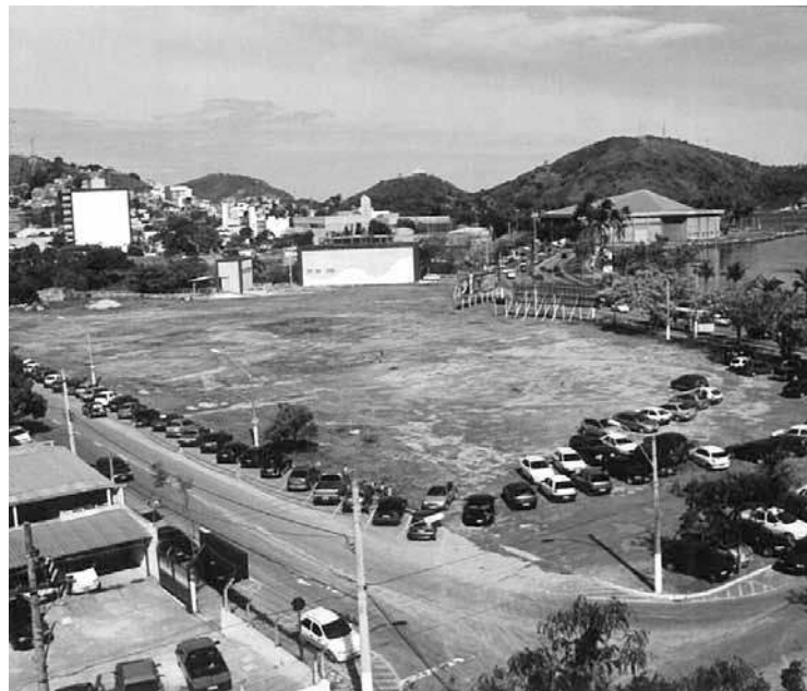
Vista do terreno onde se encontra a atual sede da SJES, antes do início das obras.
