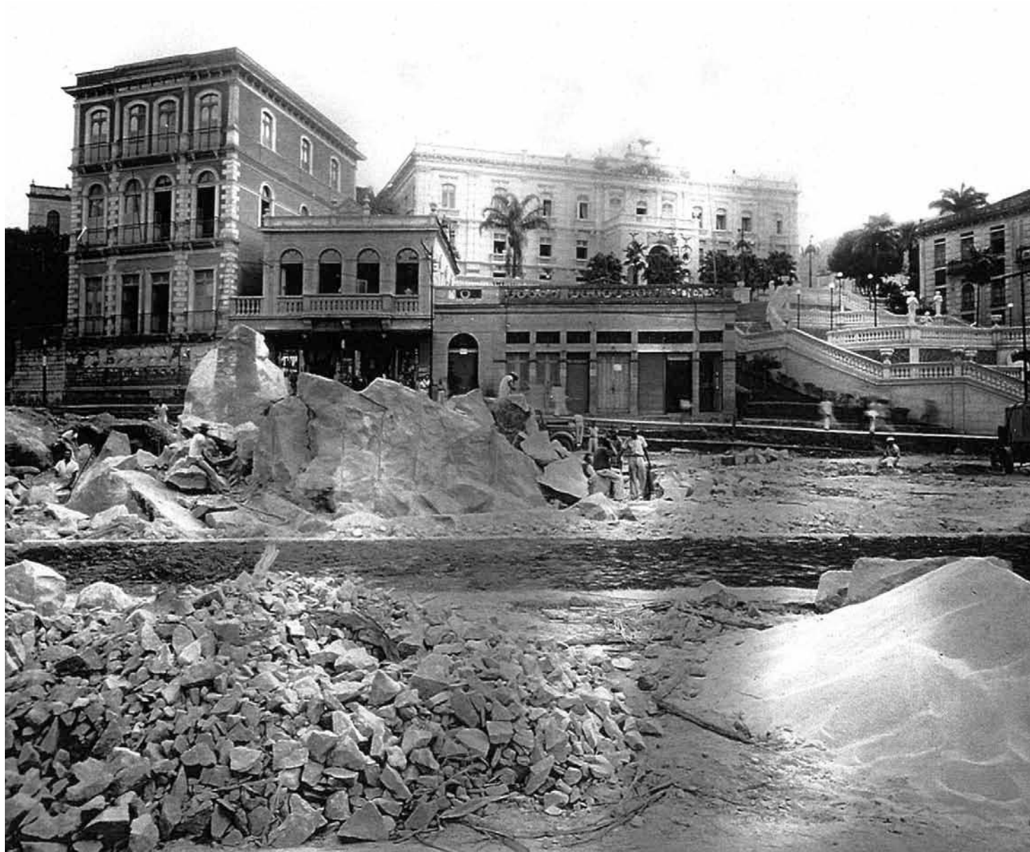
Vista frontal do prédio onde funcionou a última sede da Justiça Federal antes de sua extinção (o mais alto, à esquerda). Foto de 1954 (Arquivo pessoal de José C. V. Tatagiba). O prédio foi demolido em 1964. No primeiro plano já se vê a área, com a antiga construção já demolida, onde seria erguido o Hotel Estoril. Ao centro se vê o Palácio Anchieta, com sua escadaria.
