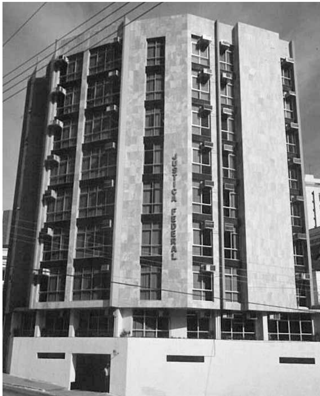
A nova sede, inaugurada em 1986, ainda sem o prédio anexo
