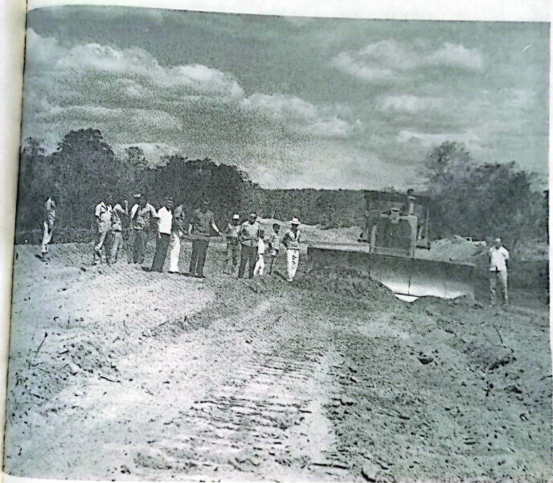
Início da construção da PI-4, Bertolândia — Cristalândia, com a extensão de 600 km.
