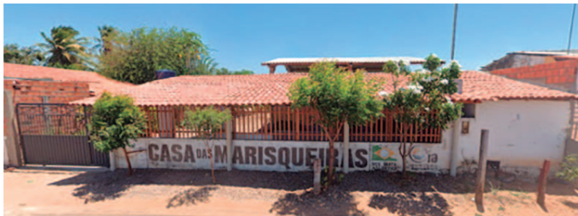
Figura 1 – Casa das Marisqueiras de Ilha Grande
